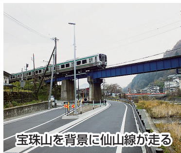
ガード下の二車線道路
